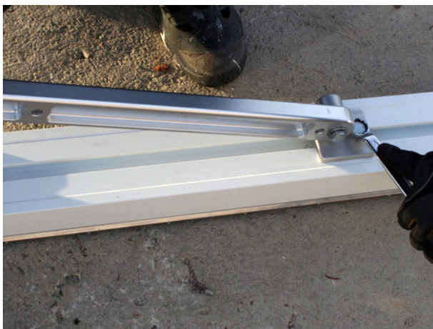
d. Trekk til den øvre bolten på festet.
