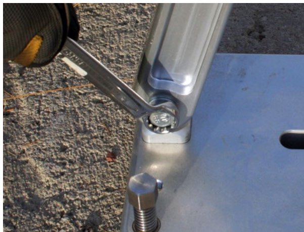
b. Lossa på den nedre bulten på staget.
