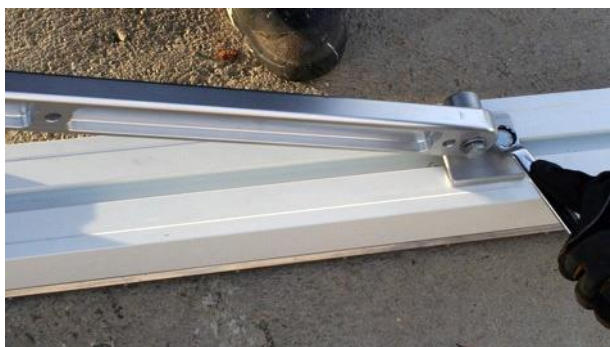
d. Spænd den øverste bolt let.
