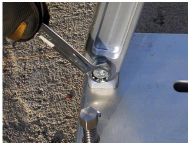
g. Spænd den nederste bolt på bagstøtten.
