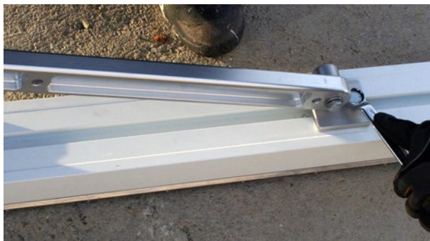
d. Serrez le boulon supérieur sans forcer.
