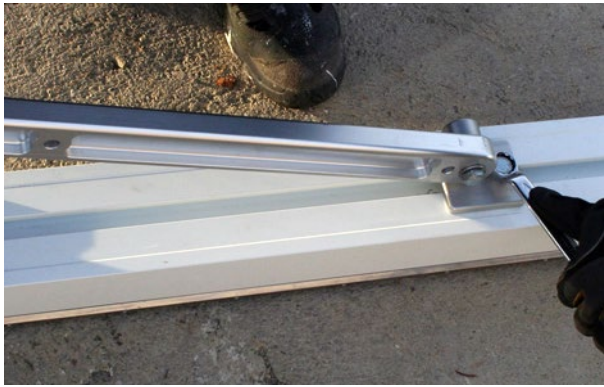
d. Ziehen Sie die obere Schraube locker zu.
