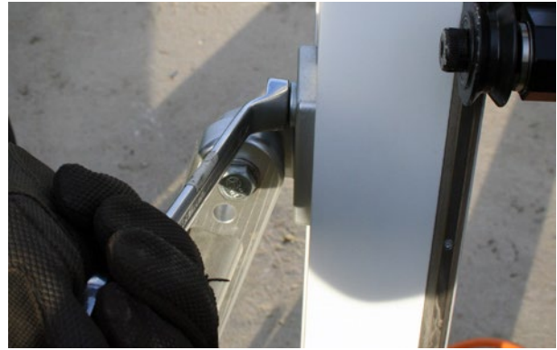
e. Wenn die Schiene aufrecht ist, ziehen Sie die Schraube ganz zu.
