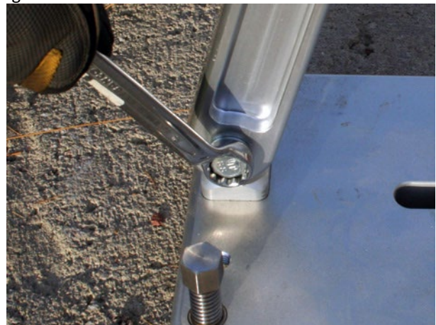
g. Die untere Schraube auf der Rückstütze zuziehen.
