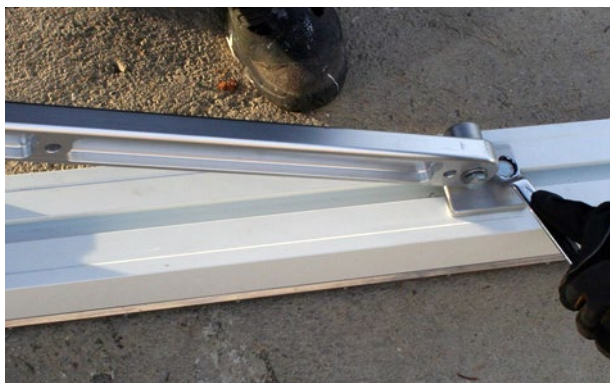
d. Trekk litt til den øvre bolten på festet.
