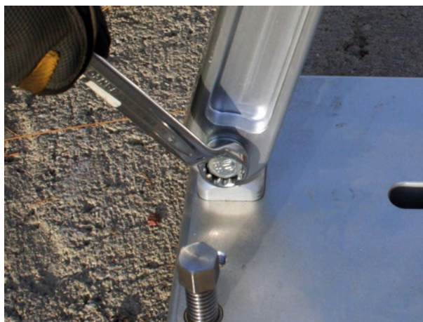
g. Trekk til den nedre bolten på staget.
