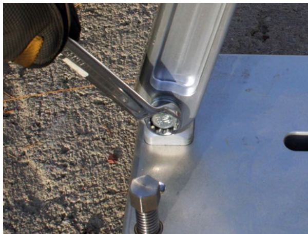
g. Apriete el perno inferior en la abrazadera trasera.
